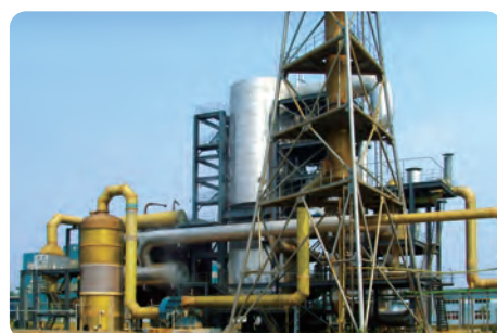
▶ 洛钼WSA wet sulfur acid制酸厂 低浓度湿法制酸
