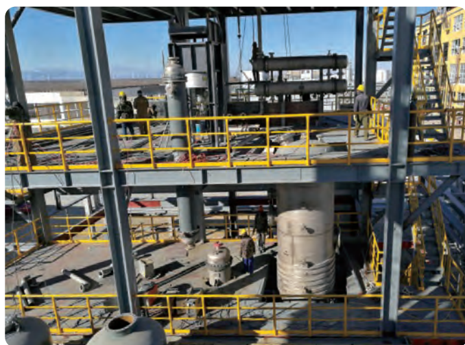
合成硫化氢项目建设现场
